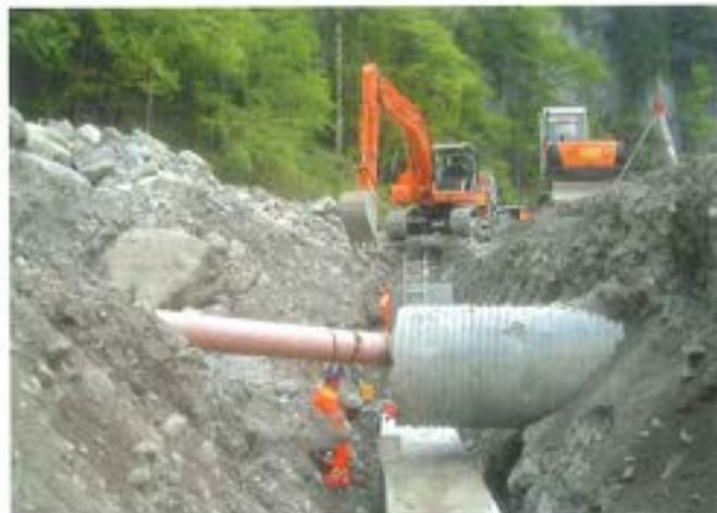
Zur Kontrolle des Rohrleitungssystems wurden Jansen-Doppelwand-Schächte versetzt; diese bestehen aus zwei getrennten Kammern. Dies ermöglicht die Überprüfung der Dichtheit des Schachtes und der angeschlossenen Doppelrohrleitung. Zur Verhinderung einer Längsdrainage sind als zusätzliche Massnahme Querriegel mit Lehm erstellt worden. Allfällig aufstauendes Sickerwasser fließt über Rohrleitungen seitlich in den Kirel.
