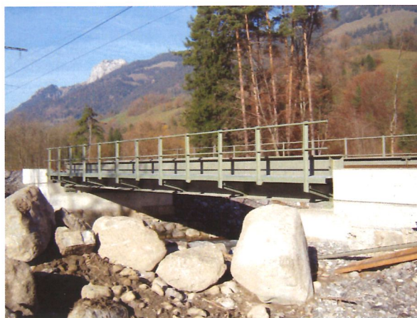
So präsentierte sich die neue Bahnbrücke im November 05. Das Bahntrasse wurde um 50cm angehoben.
