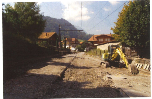
Am Bahnhof werden die Geleise aus dem Boden gerissen...
