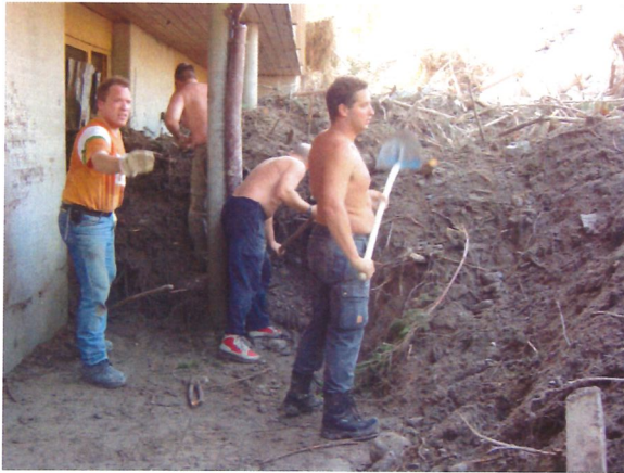
Hinter dem Schulhaus wird geschaufelt und geschaufelt...!
