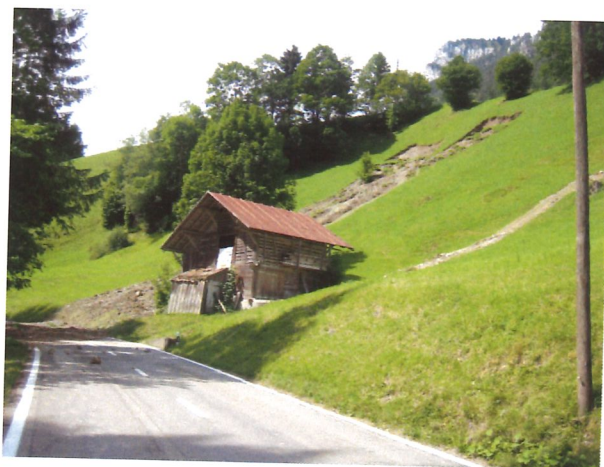
Murgang entlang der Strasse.
