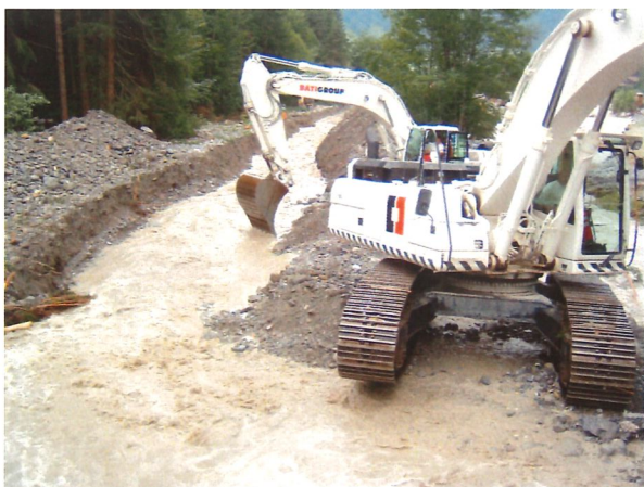
Fieberhaft versuchen die grossen Baumaschinen am 26. August den Chirel wieder umzuleiten.
