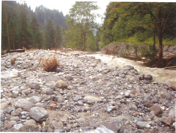
An die Strasse erinnert nur noch die Stützmauer (rechts).
