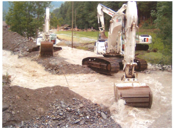
Das Umleitungsunterfangen gelingt nach einigen 24-Stunden Einsätzen der Baggerführer.
