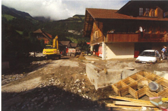
Bereits wird am 26. August im Dorf gebaggert. Das Wasser ist seit knapp 24 Stunden aus den Strassen.
