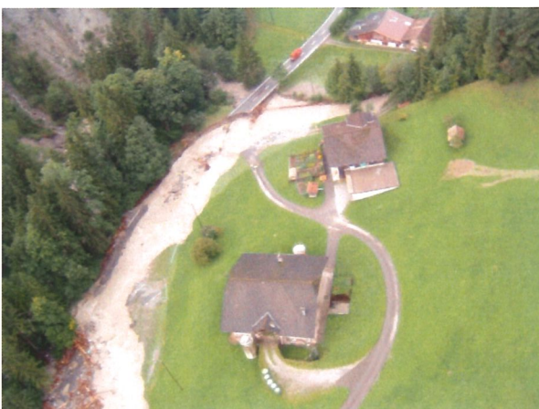
Wie hier, fehlen weite Teile der Dientigtalstrasse. Die Häuser stehen bedrohlich nahe am Wasser.
