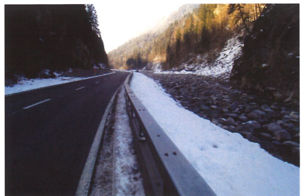
Grosse Teile des Waldes im Talboden mussten aus Sicherheitsgründen abgeholzt werden. Die Strasse und der Chirel sollen künftig genügend Platz nebeneinander haben.
