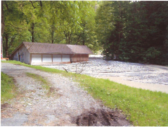
Der Schiesstand oberhalb von Oey wurde vom Geröll eingegraben.
