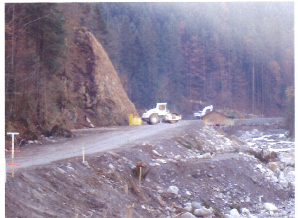
Anfang November 05 waren die Bauarbeiten an der neuen Diemtigtalstrasse noch in vollem Gange. Bereits zu diesem Zeitpunkt zeichnete sich die neue, grosszügige Linienführung ab.
