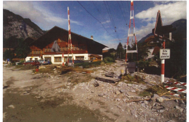
Das Bahntrasse ist zugedeckt.
