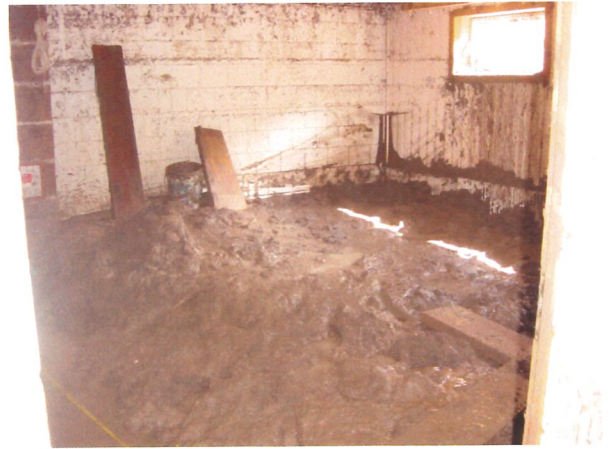
Der Schlamm muss schlussendlich noch abgesaugt werden. Er ist zu schwer für die Helfer mit Schaufeln.
