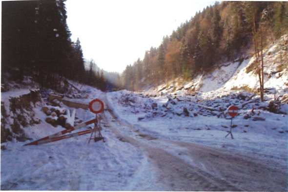
Noch für lange Zeit werden die Wunden im oberen Chirel sichtbar sein. Vorallem hier wälzten sich die grossen Wassermassen durch und veränderten das ganze Tal.
