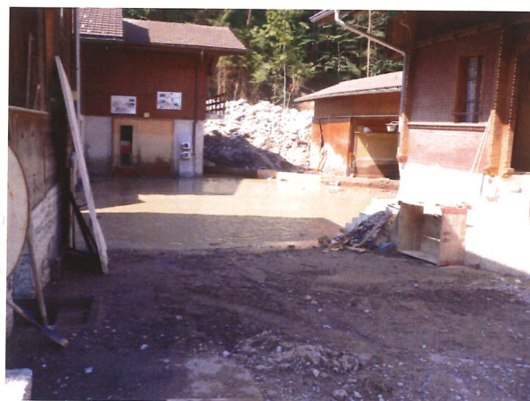
Noch lange läuft das Wasser im Dorf nicht richtig ab. Die Häuser wurden arg in Mitleidenschaft gezogen.
