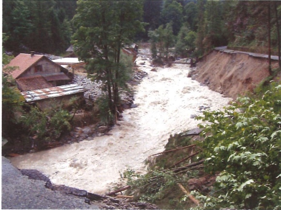
Blick auf die ehemalige Zimmerei im Horboden. Viel ist nicht mehr übrig!
