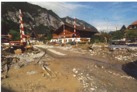
Gesamtansicht des Bahnübergangs und des Gemeindehauses.
