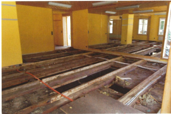
In diesem Haus wurde bereits der ganze Boden herausgerissen.
