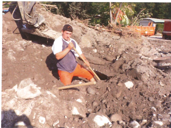
Hier gibt es noch einiges zu schaufeln.
