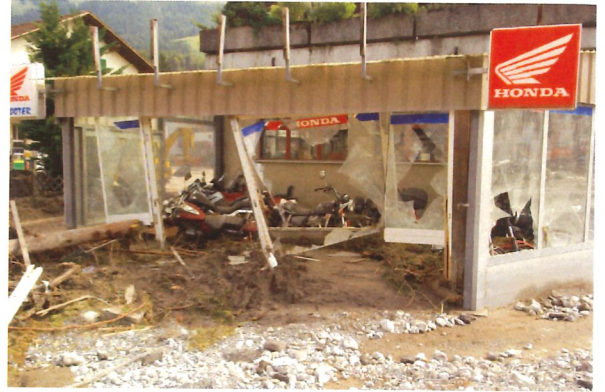
Aus dem Motorradladen „Highway 101“ ist nichts mehr zu retten. Zuviel Schutt hat das Wasser in die Verkaufsräume und die Werkstatt gepresst.
