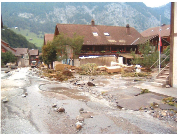
Auf grossen Strecken ist die Dorfstrasse unterspült. (26. August 2005)
