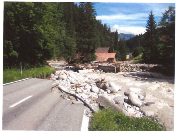
Der ehemalige Brückenbereich im Horboden. Gut zu sehen ist der immense Platzbedarf des Baches.
