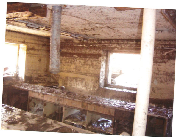
Hier muss alles herausgerissen werden, was nicht von statischer Bedeutung ist.
