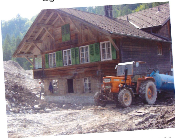
Wahrscheinlich hat auch dieses alte Haus noch nie ein solches Hochwasser erlebt.
