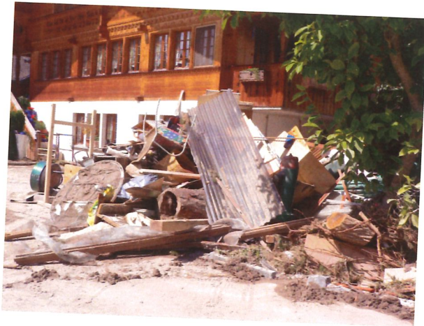
Die ersten Häuser werden ausgeräumt. Eine logistische Herausforderung auch für die SOGES und die AVAG.
