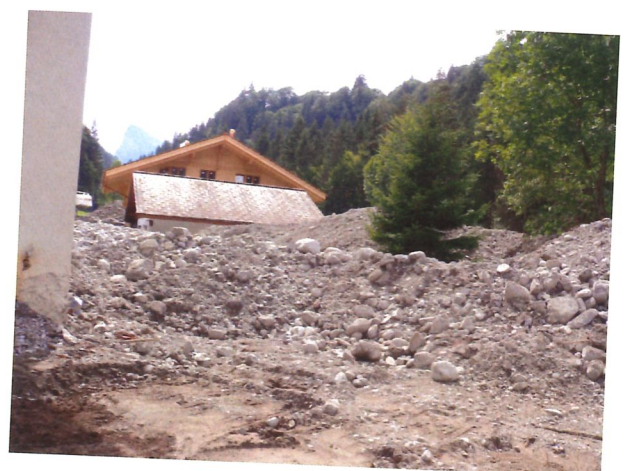
Im Oberdorf ragen nur noch die Dächer der Häuser aus den Geröllbergen. Hier ein Neubau.
