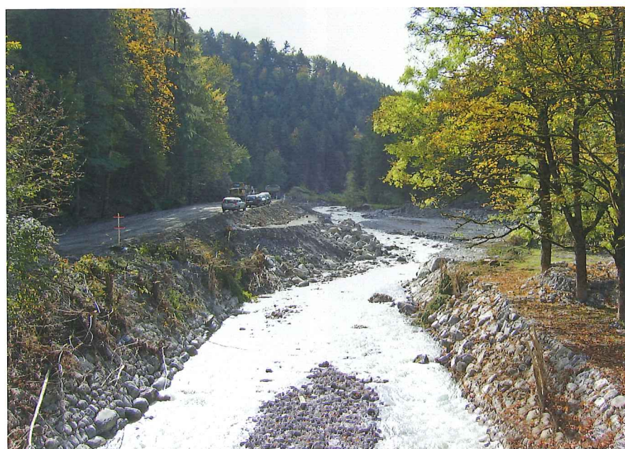
Oben: Blick von der Katzenlochbrücke Richtung Dorf Oey.
