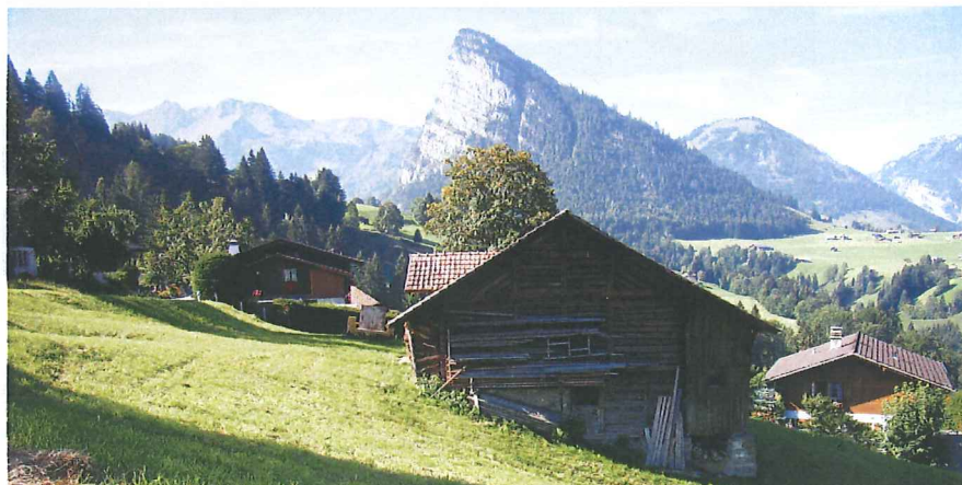
Abb. 2: Bestehende Gebäude in der UeO «Ferienhauszone Rothbad»
