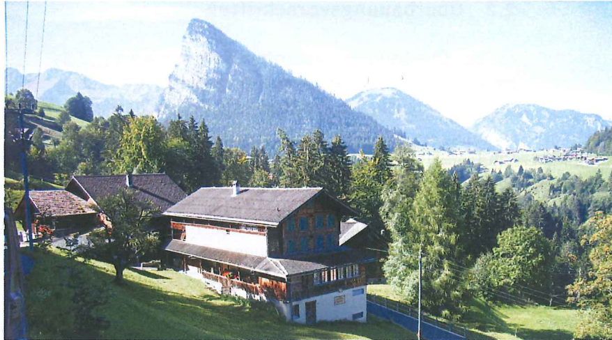
Abb. 3: Bestehendes Restaurant Rothbad
